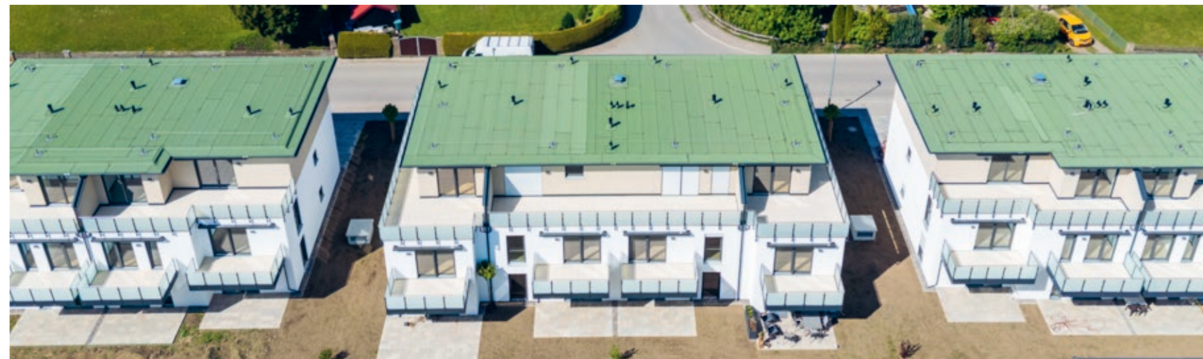
„Leben am Flößerpark“, Aitrach (Fertiggestellt)
